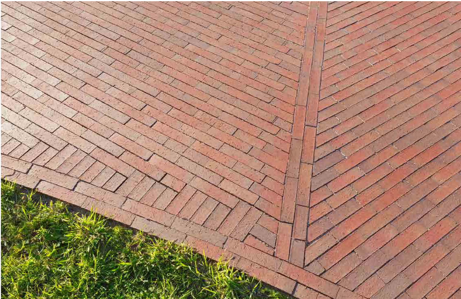
Bad Zwischenahn-Wehnen, Karl-Jaspers-Klinik Bunt 04, ohne Fase, backsteinrau, 220x52x80 mm Fotos: © Ulrich Hoppe
