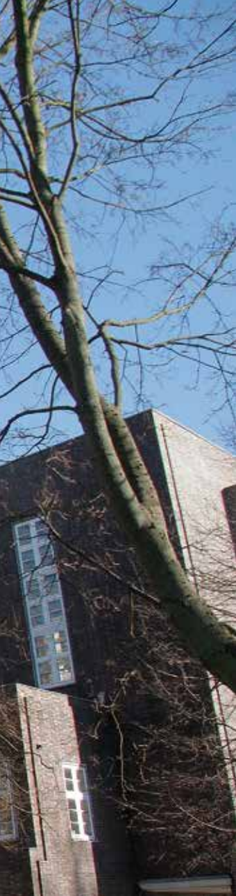
Oben: Zu sehen ist die Südseite des Wilhelmshavener Rathauses. Die Lichtbänder und Stege an der Turmfront und Turmrückseite des Wilhelmshavener Rathauses deuten einen Stufengiebel an.
