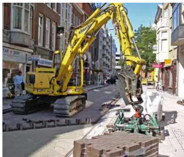
Maschinenverlegung von Pflasterklinker, Den Haag, Niederlande
