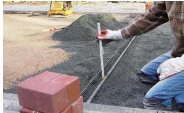
Abb. 5-9: Abziehen der Oberfläche der Bettung unter Verwendung von zuvor ausgerichteten Metallschienen
