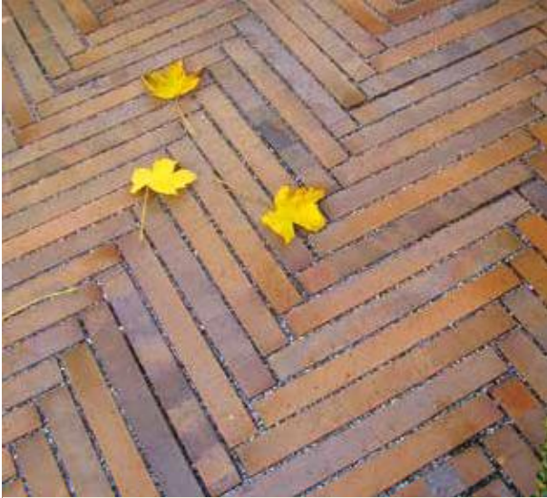
Pflasterklinker als Langformat verlegt im Fischgrätverband
