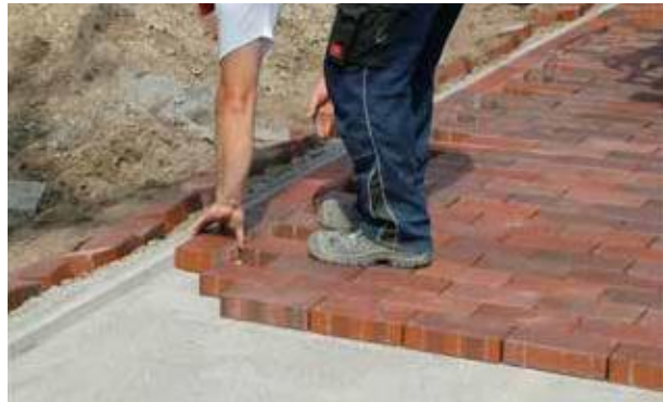
Abb. 5-11: Handverlegung von Pflasterklinkern
