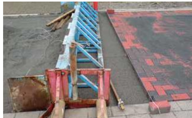
Abb. 5-10: Abziehen der Oberfläche der Bettung unter Verwendung der Lehre
