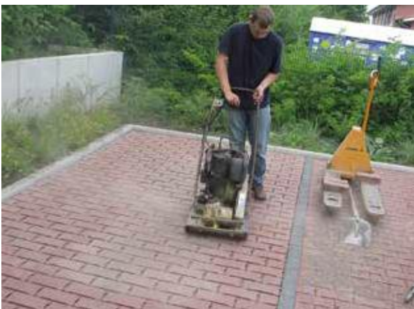
Abb. 5-15: Abrütteln der zuvor abgekehrten Klinkerpflasterfläche mit einer leichten Vibrationsplatte
