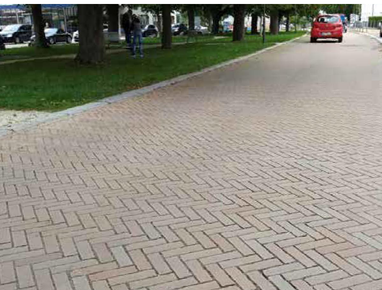
Rechtecksteine diagonal zur Fahrtrichtung wirken geräuschemindernd
